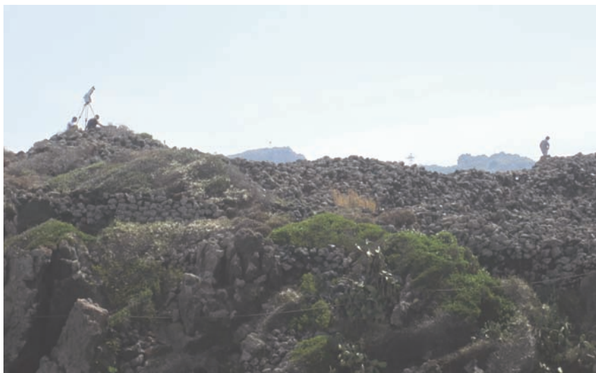
Fig. 4 – Vista parziale del muro perimetrale
